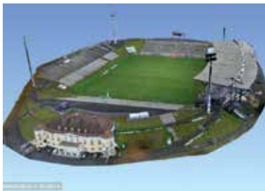
Das fertige Gesamtbild des Stadions aus Fotos und Laserscanning.
